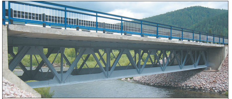
Отремонтированный мост через р. Жержул в Манском районе. 2008 г.
