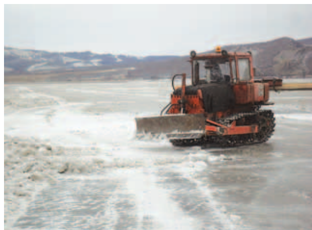
Очистка ледовой переправы от снега
