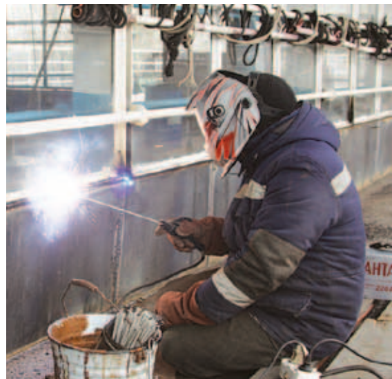
Ремонтные работы на дебаркадере «Красноярск»
