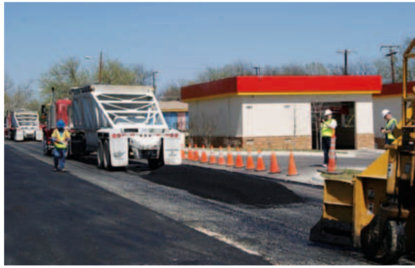
Разгрузка асфальтовоза перед подборщиком
