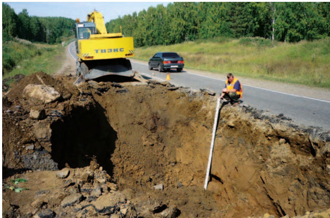
Ликвидация пучины на автодороге М-53 «Байкал»
