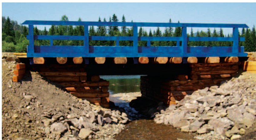
Пример проведения ремонтных работ по устранению последствий паводка 2012 года. Партизанский район, автомобильная дорога Партизанское – Мина, 66-й км
