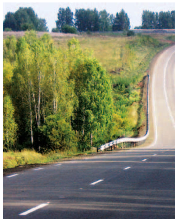
Вводной участок автодороги Черниговка – Новогорodka после ремонта
