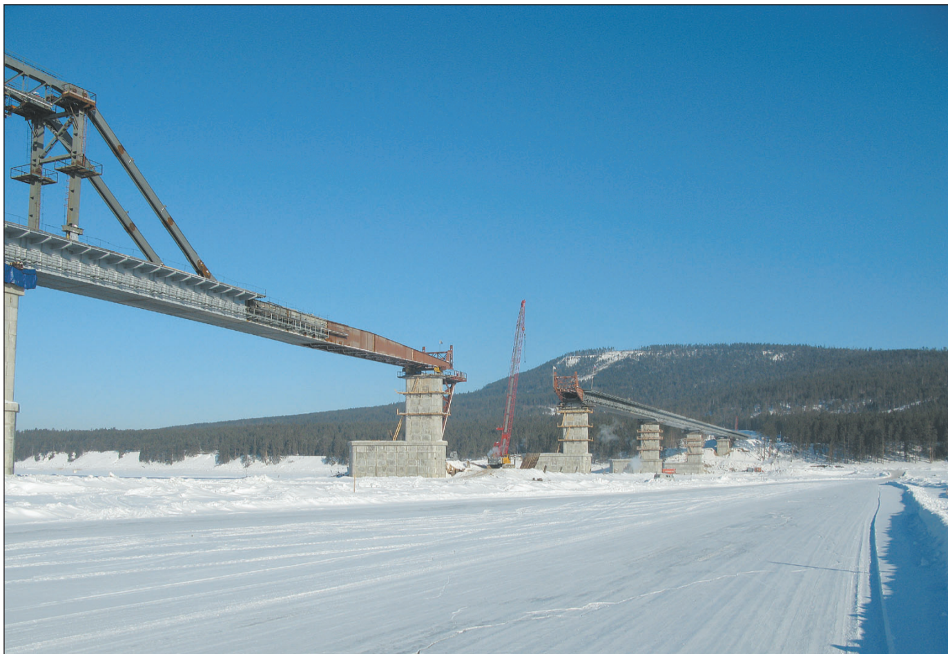
Строющийся мост через Ангару. Февраль 2011 года.
