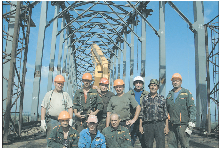
Бригада мостостроителей на строительстве мостового перехода через р. Енисей на глубоком обходе Красноярска
