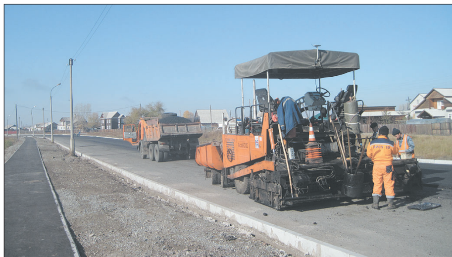
Ремонтируется ул. Пушкина в Шушенском
