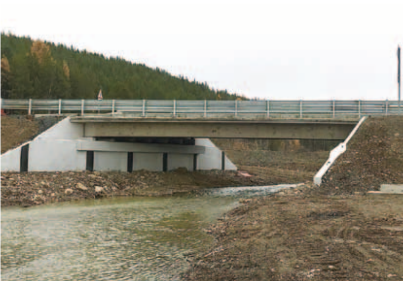
Мост через реку Огня
