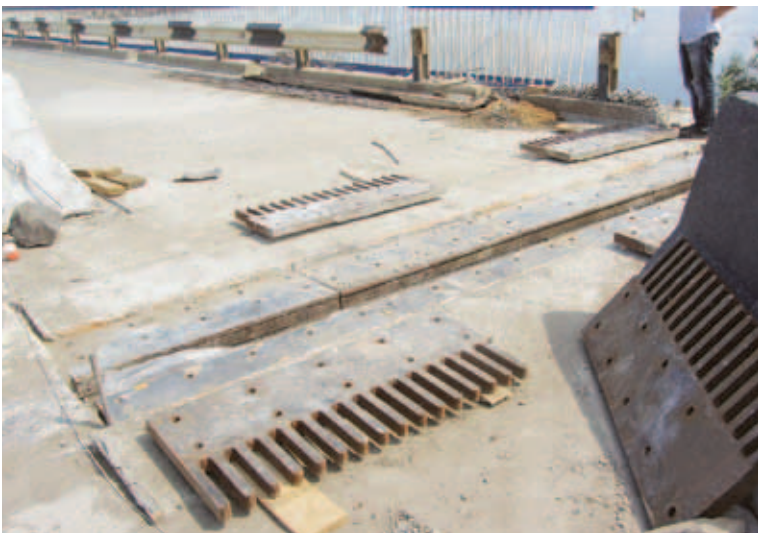
Замена деформационных швов
