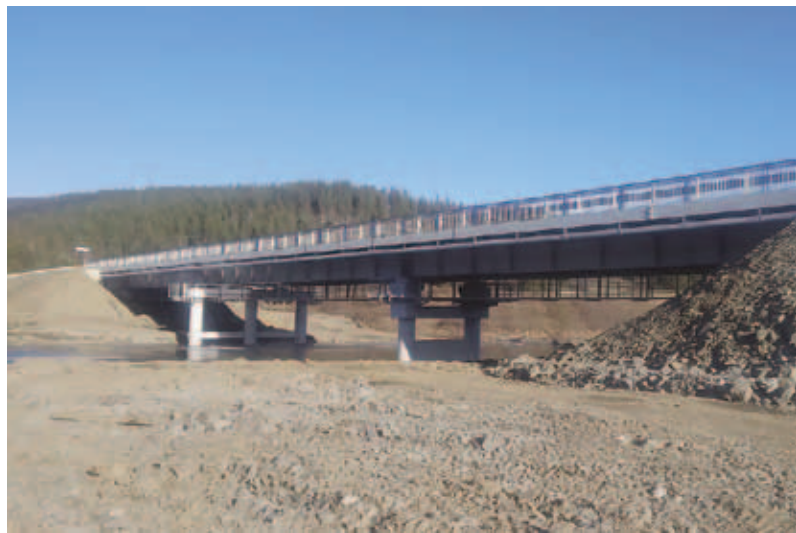
Мост через реку Ведуга
