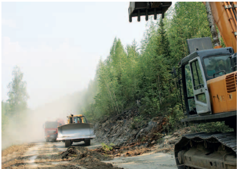
Восстановительные работы на дороге
