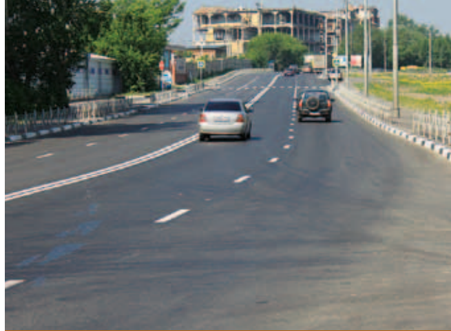
Красноярск. Улица Калинина после реконструкции
