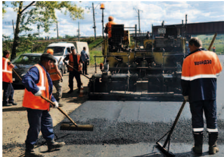
Ведется укладка асфальтобетонного покрытия
