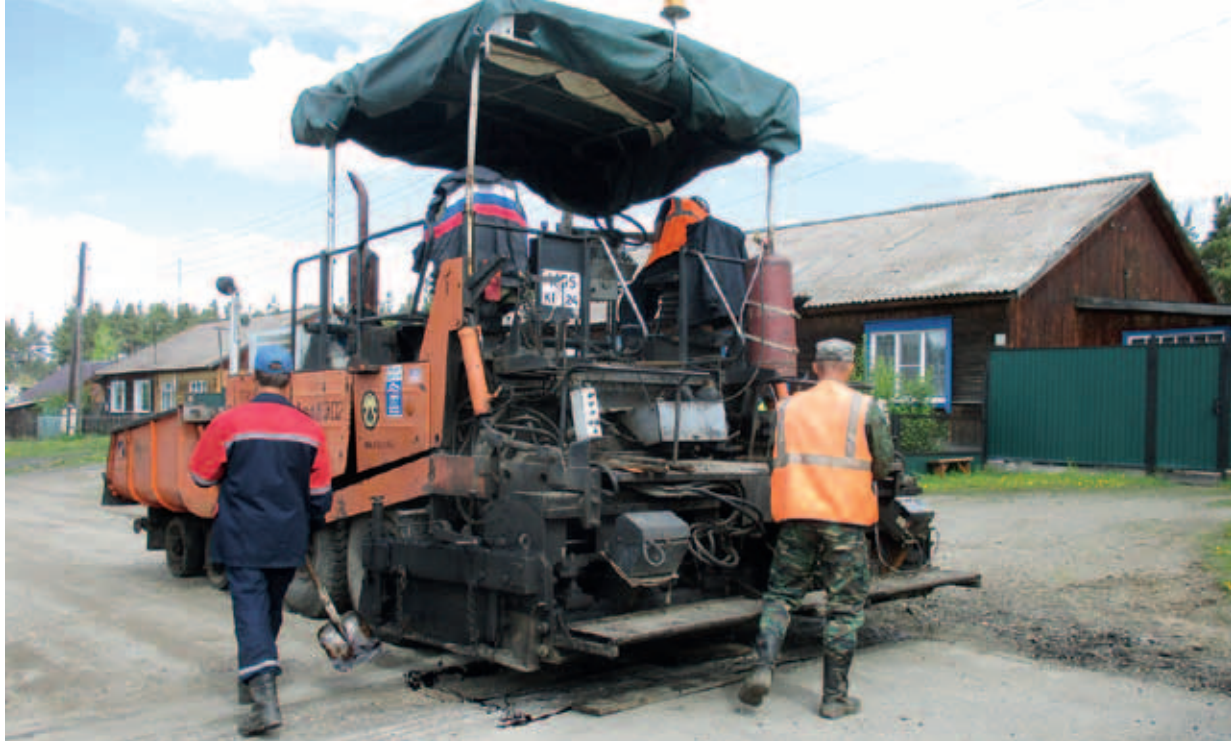
Укладка асфальта на улице Мира в селе Ермаковском
